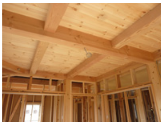
2階子供室 天井の仕上り
