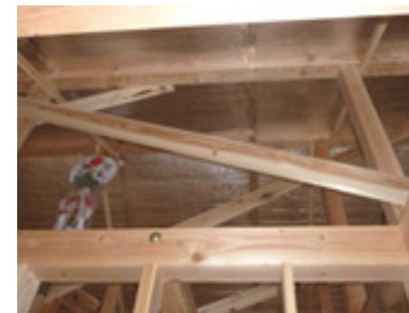
2階遮熱材の様子
