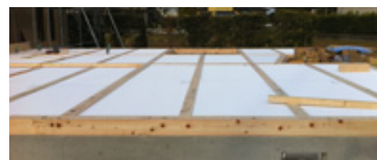
床断熱材施工後
