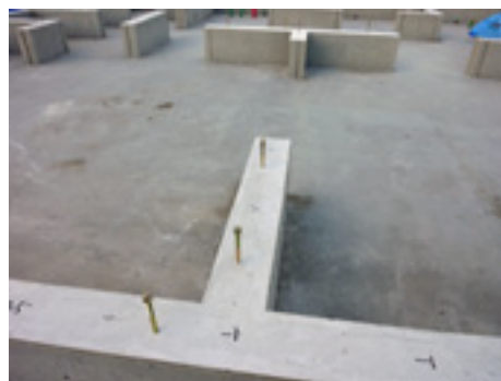
基礎工事完成
