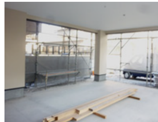
駐車場は土間の仕上げと照明器具の取付工事が残っています
