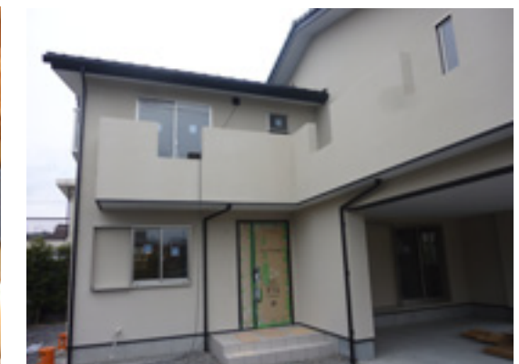
外壁の吹付け工事が終わりました
