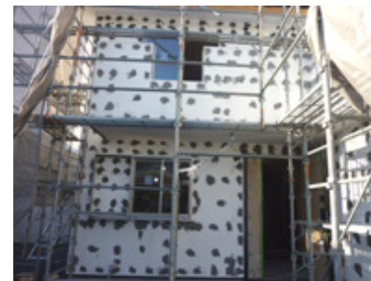
～外壁のワッシャー塗り込みの様子～
