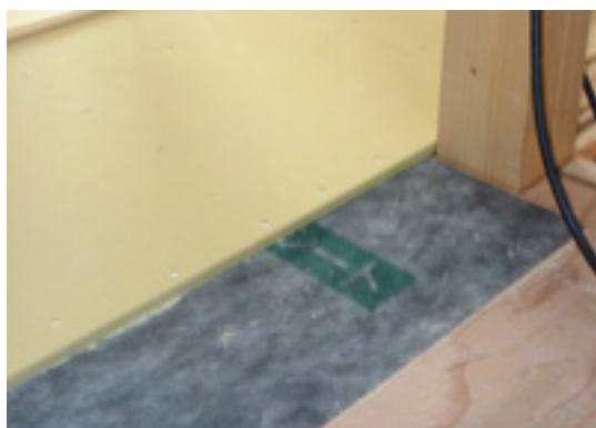
～合板下地+遮音シート+遮音用PBボード～
