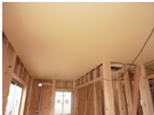
～クロス下地 (PB ボード張り)～
