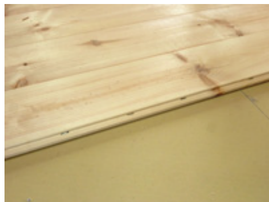
～パインフローリングの留め方～
