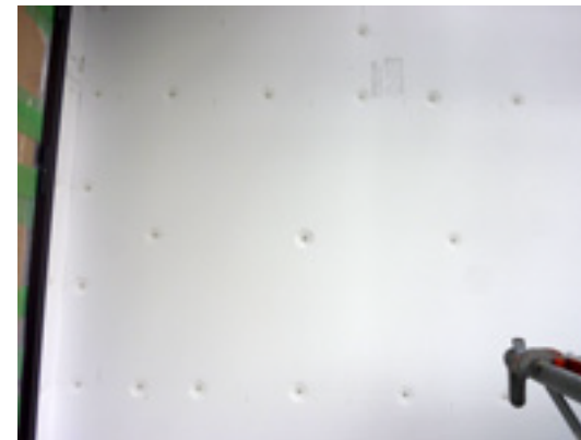
~EPSボードをワッシャーで取付したところ~
