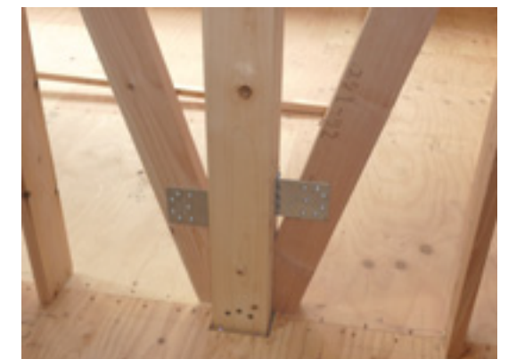
~筋交い施工状態、金物取付~
