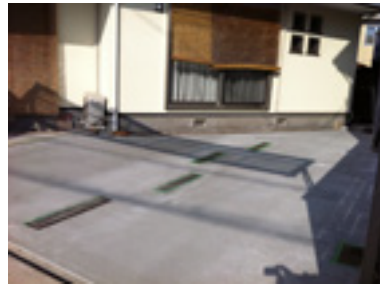
コンクリート打ちにしました。
