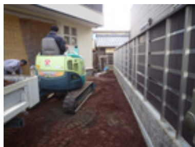
砂利敷きだった駐車場を・・・
